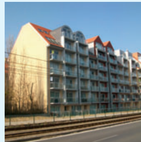
Residentie "Elisa 2" • Nieuwpoort (B) • 2008 Arch. Vandecaetsinne • Aannemer Durabrik
