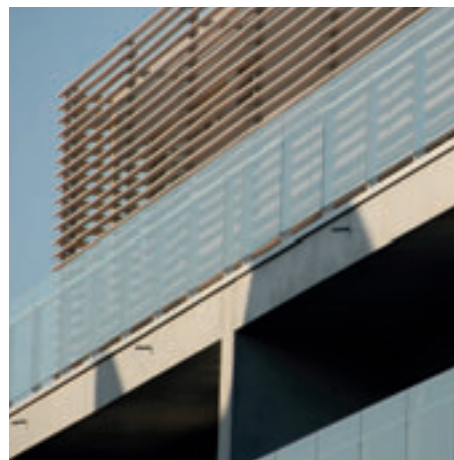
Residentie "Broersbankhelling" • Oostduinkerke (B) • 2007 Arch. Marc Corbiau/Arch. PVL • Aannemer Furnibo
