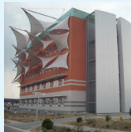
Eole • Gosselies (B) • 2006 Arch. Bureau d'étude IGRETEC • Aannemer SM Bemat - Moury
